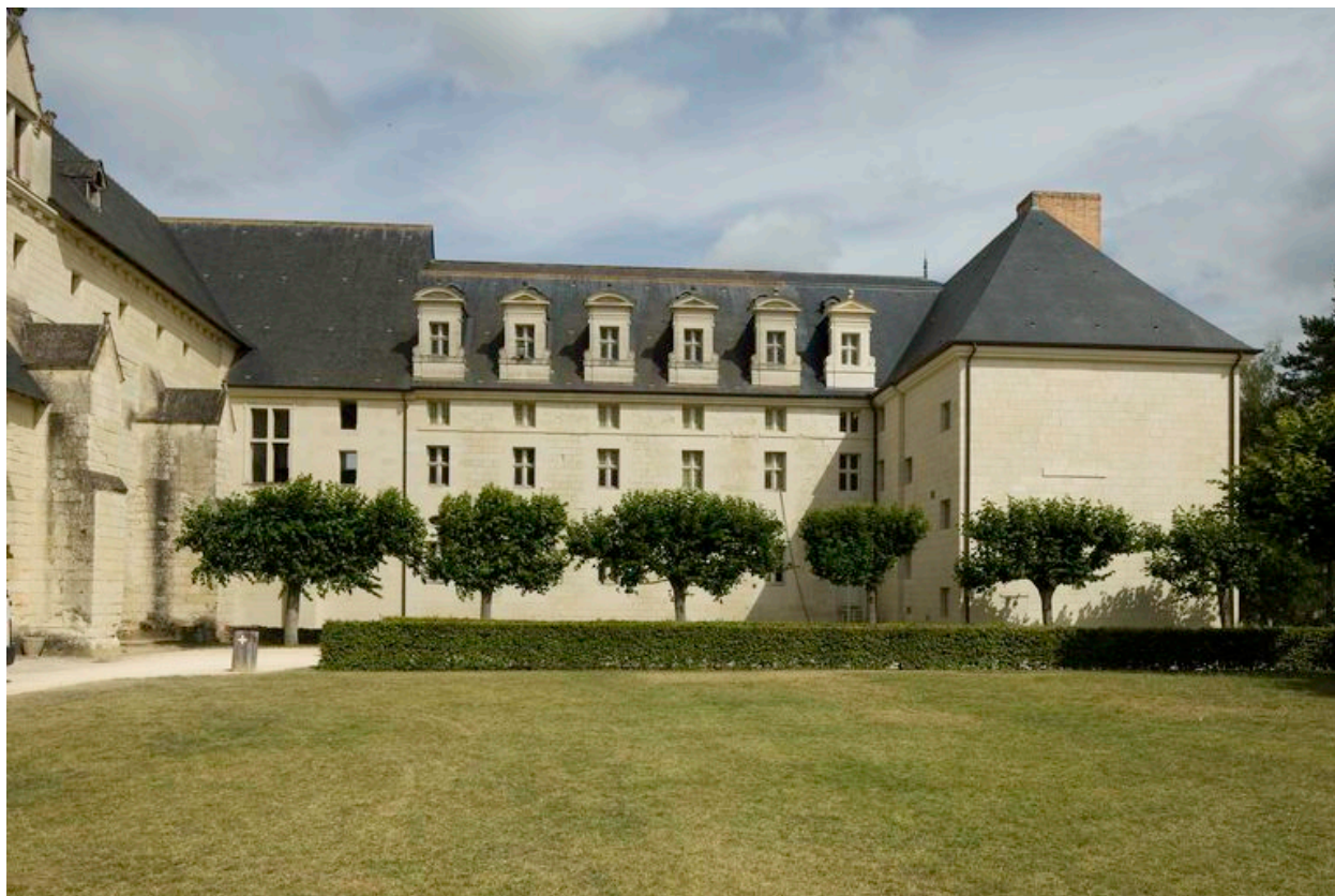
Prolongement sud de l'aile est du cloître, noviciat (vers 1685), façade ouest.
