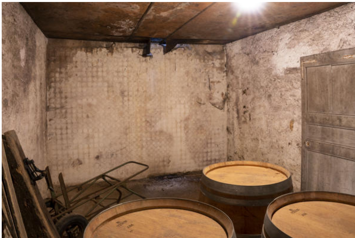
Détail d'une cellule de stockage des bouteilles.
