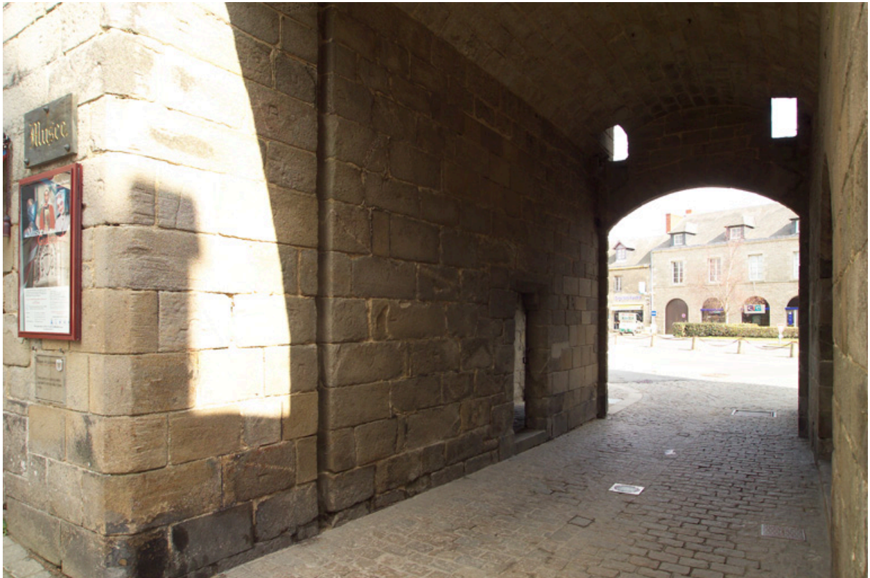
Vue du passage, parement nord.
