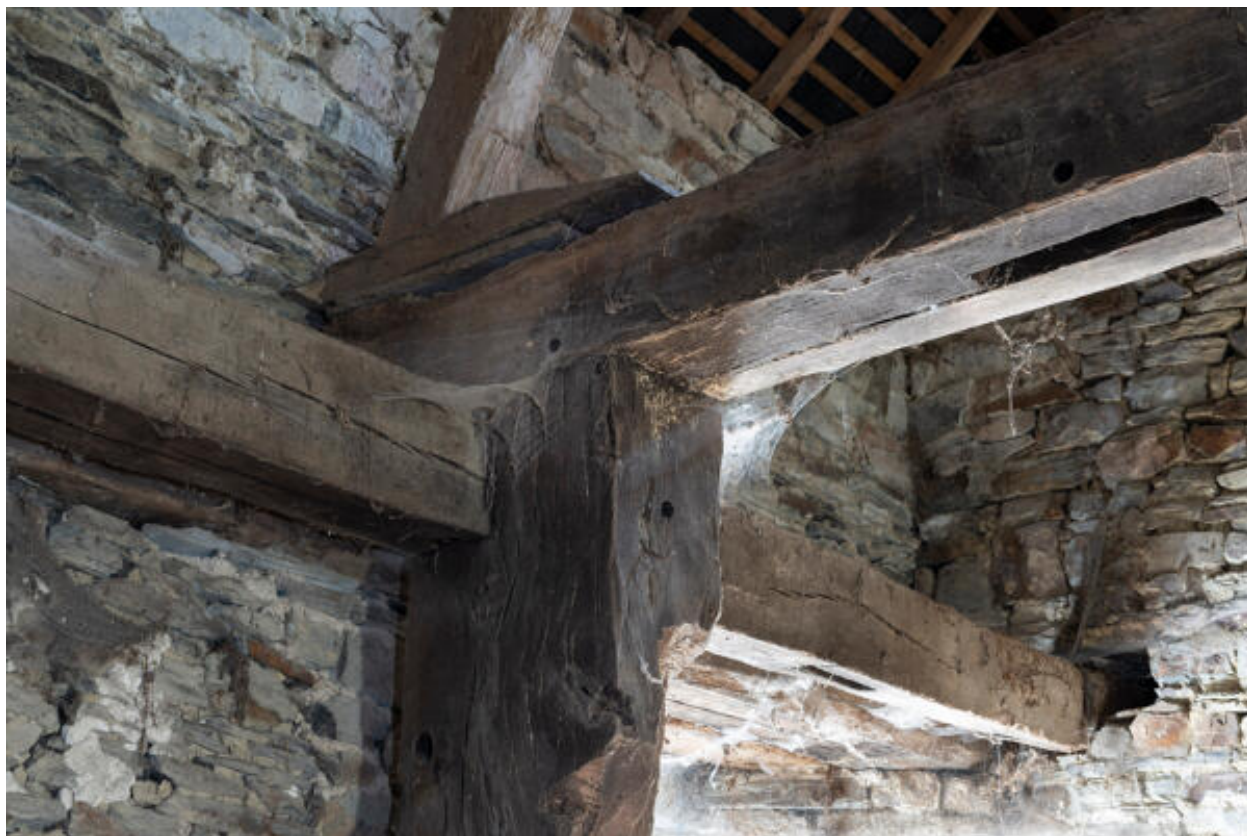
Assemblage poteau ouest, sablière, entrain (logis nord, salle haute).
