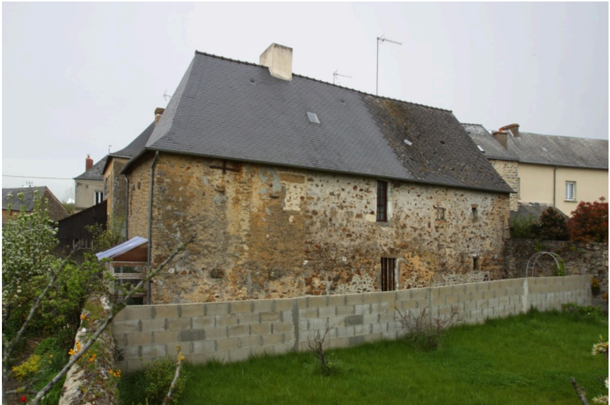
La façade postérieure vue depuis l'est.
