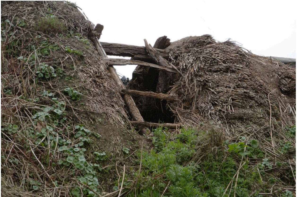
Détail de la couverture en roseau du toit à porcs.
