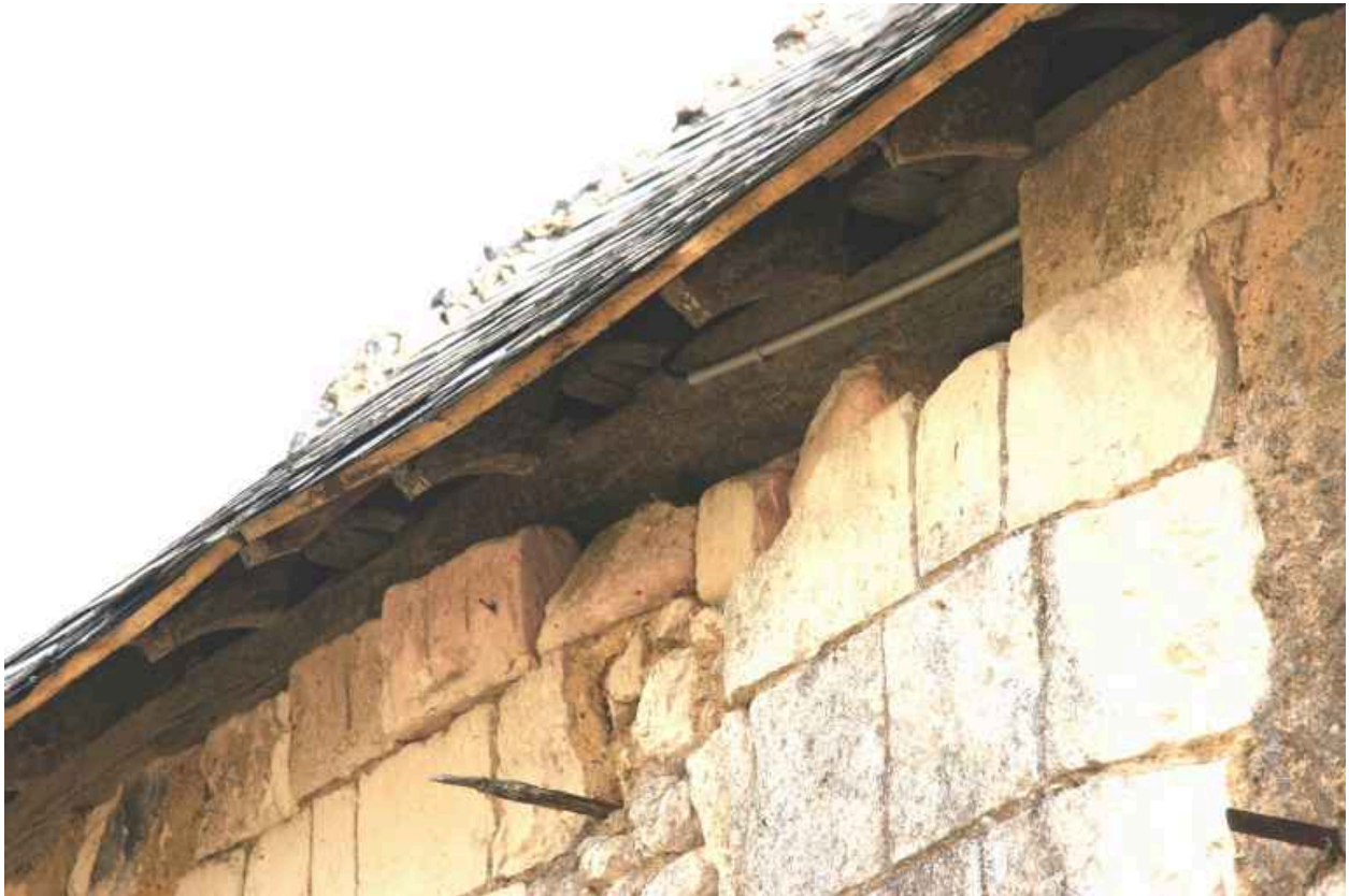
Mur droit de la nef, détail : coyaux.
