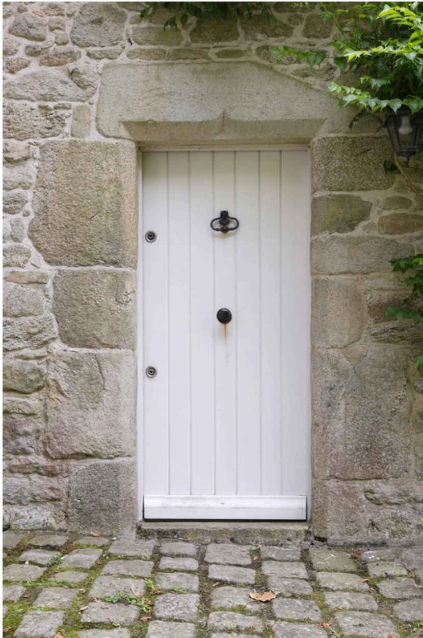
Logis. Aile ouest. Porte sur le mur gouttereau est.
