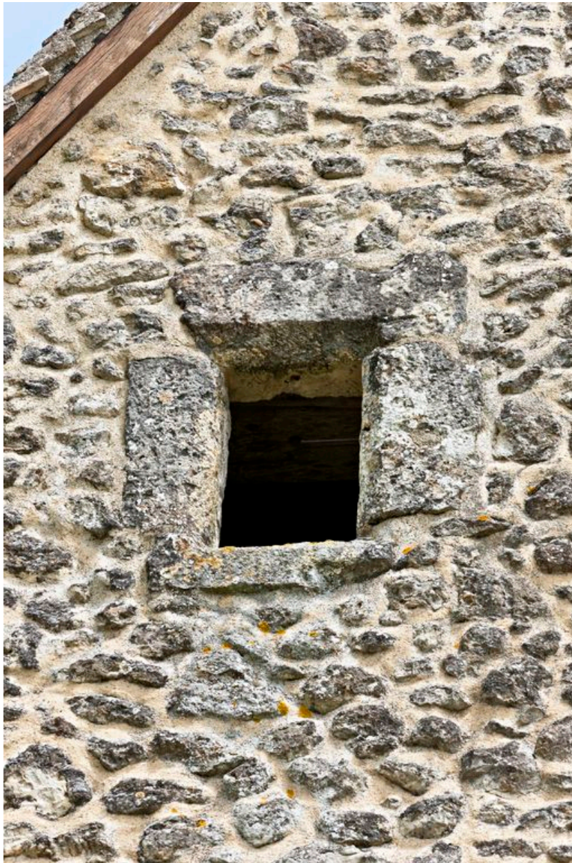
Fenêtre du comble dans le mur-pignon droit du logis
