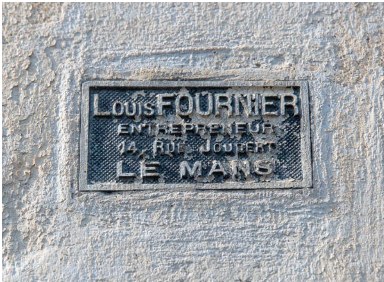
Vue de la plaque d'entrepreneur sur la maison Levesque avenue Rubillard.
