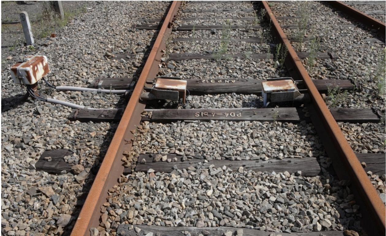
Pédales de réarmement, électromécaniques, PN 312, côté Nantes.
