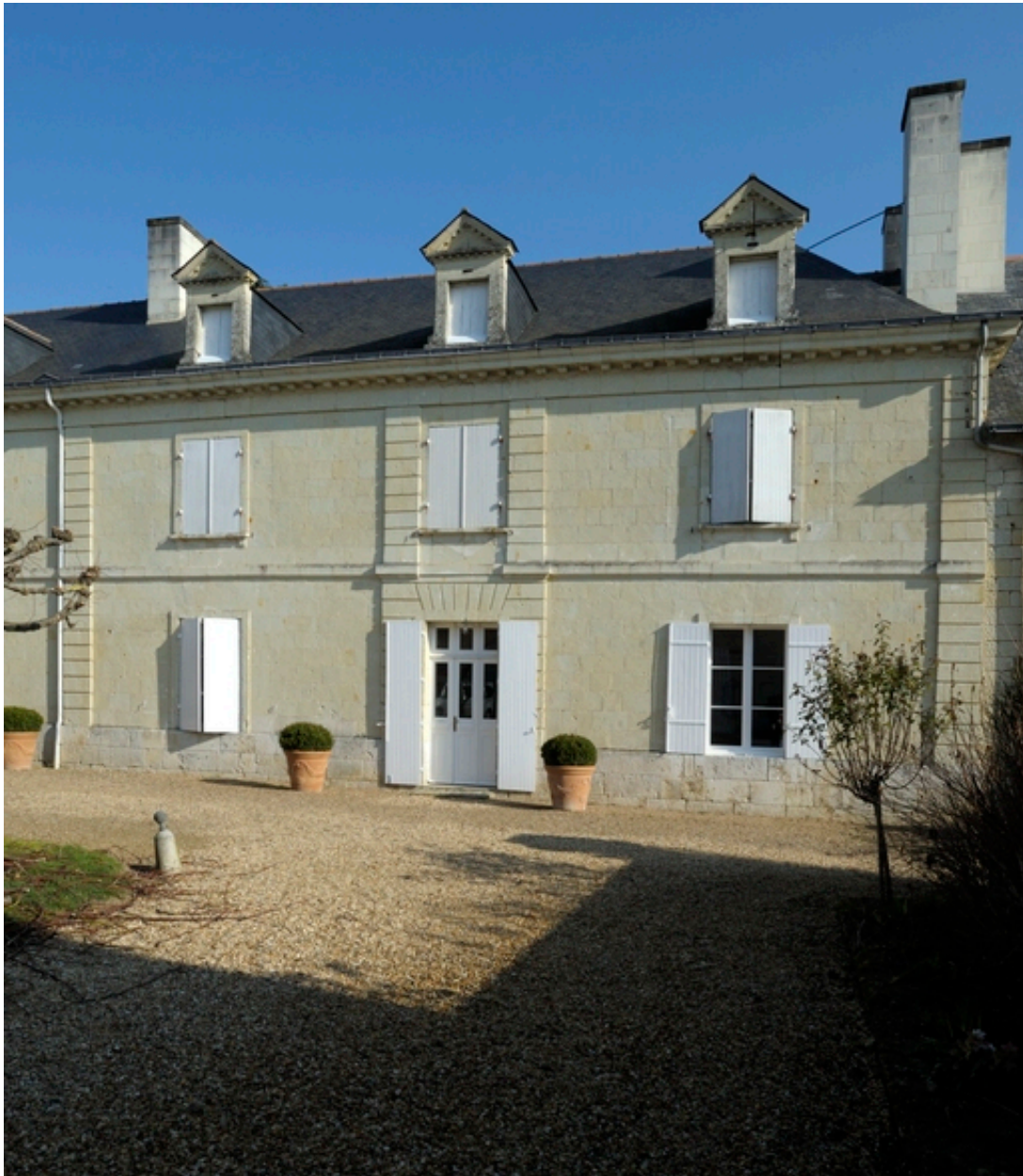
Logis. Corps central, façade sud, détail de la partie est (2).
