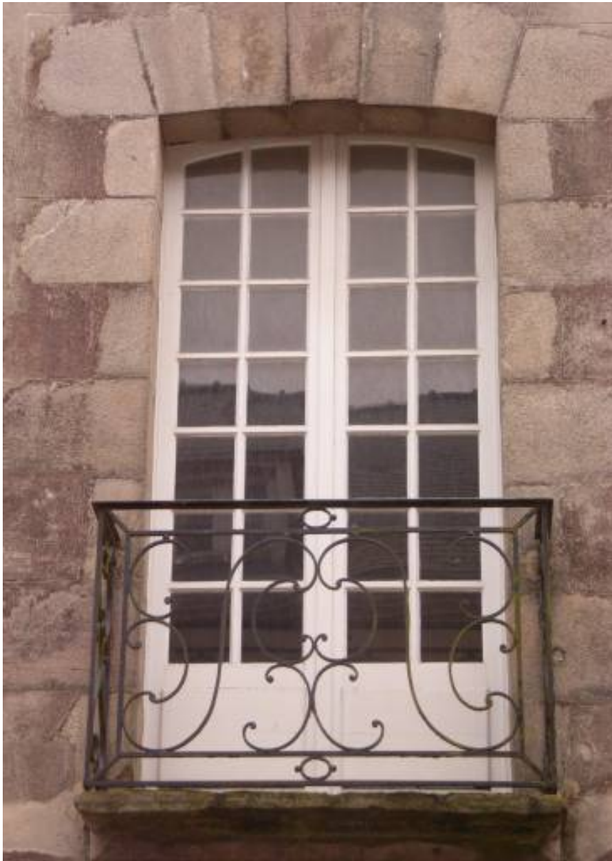
Détail d'une porte fenêtre.
