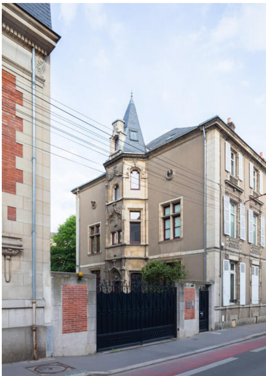
Vue de la façade latérale de la maison.
