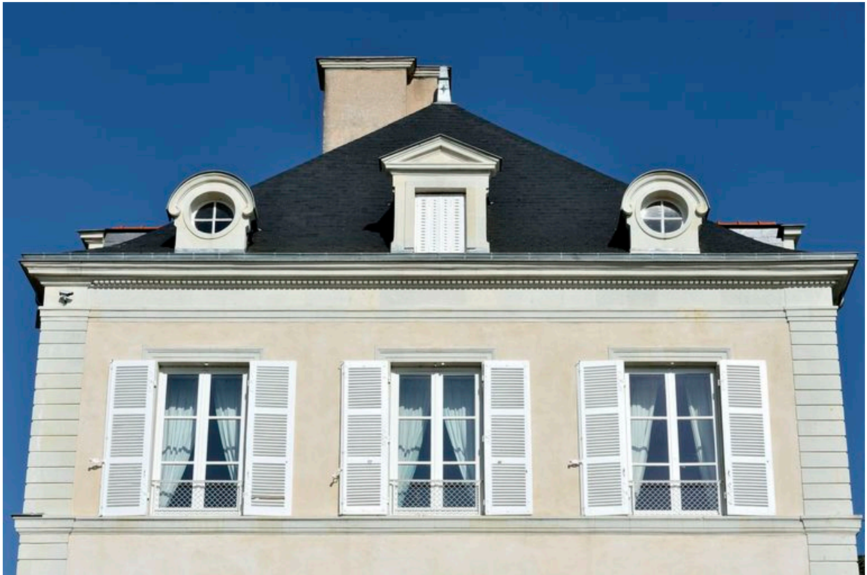
Baies de la façade est.
