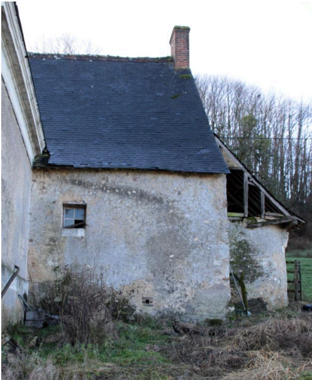
Maison, façade postérieure de la buanderie : petite baie de l'escalier.
