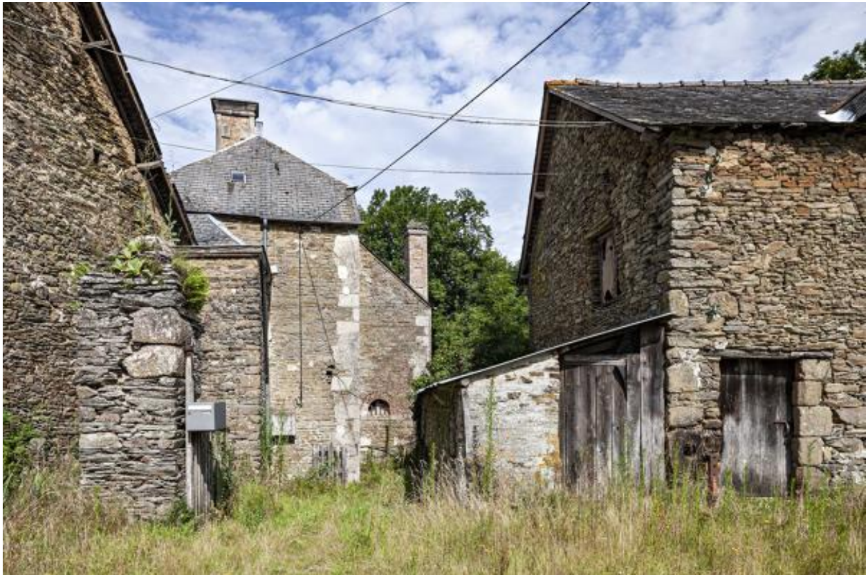
Le château de la Grivellière, aperçu entre les deux corps de logis du hameau.
