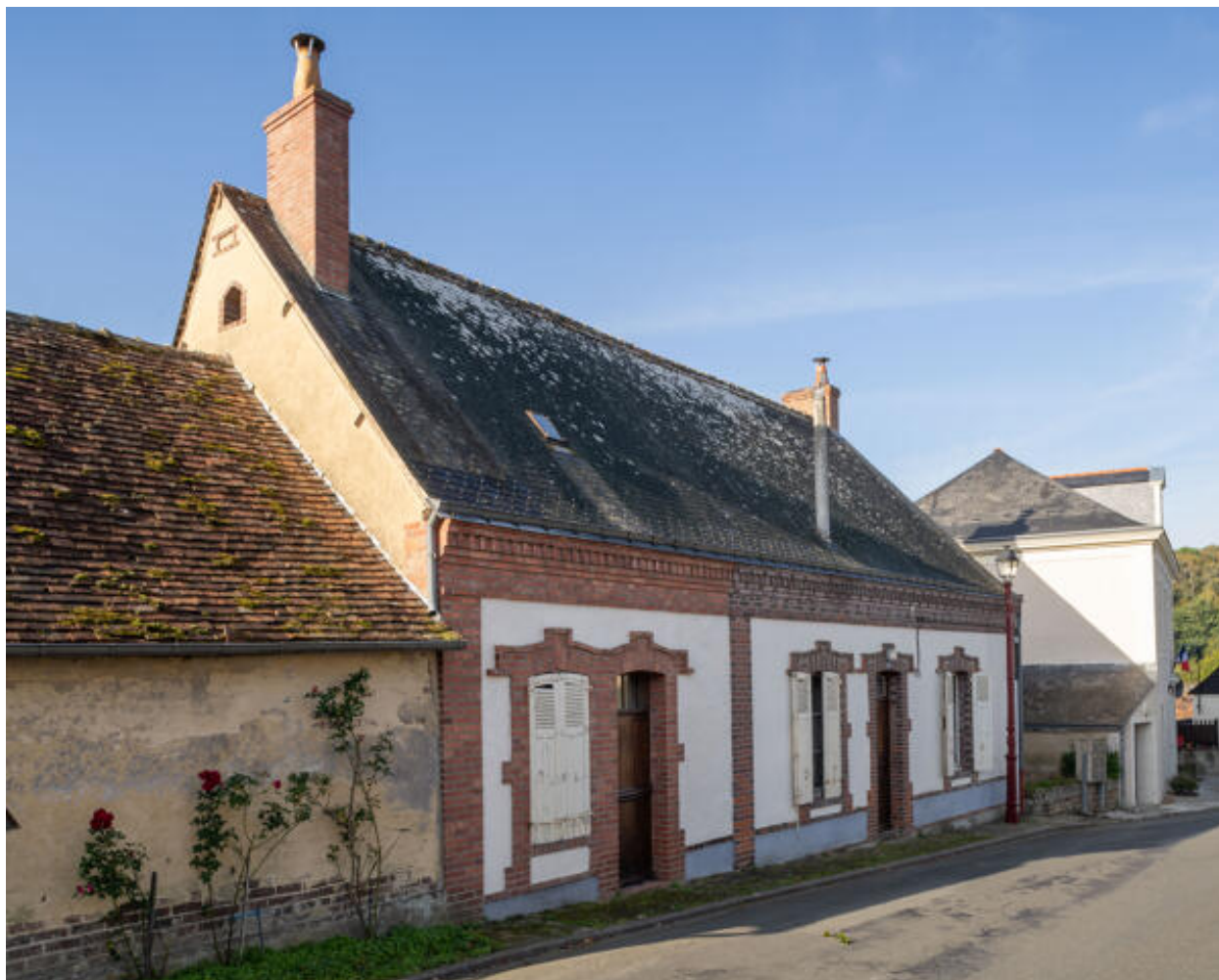
Maison, 10 rue de la Petite Fontaine.
