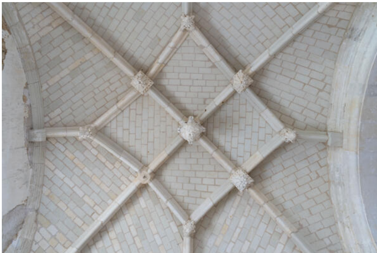
Chapelle latérale : voûte de la travée ouest.
