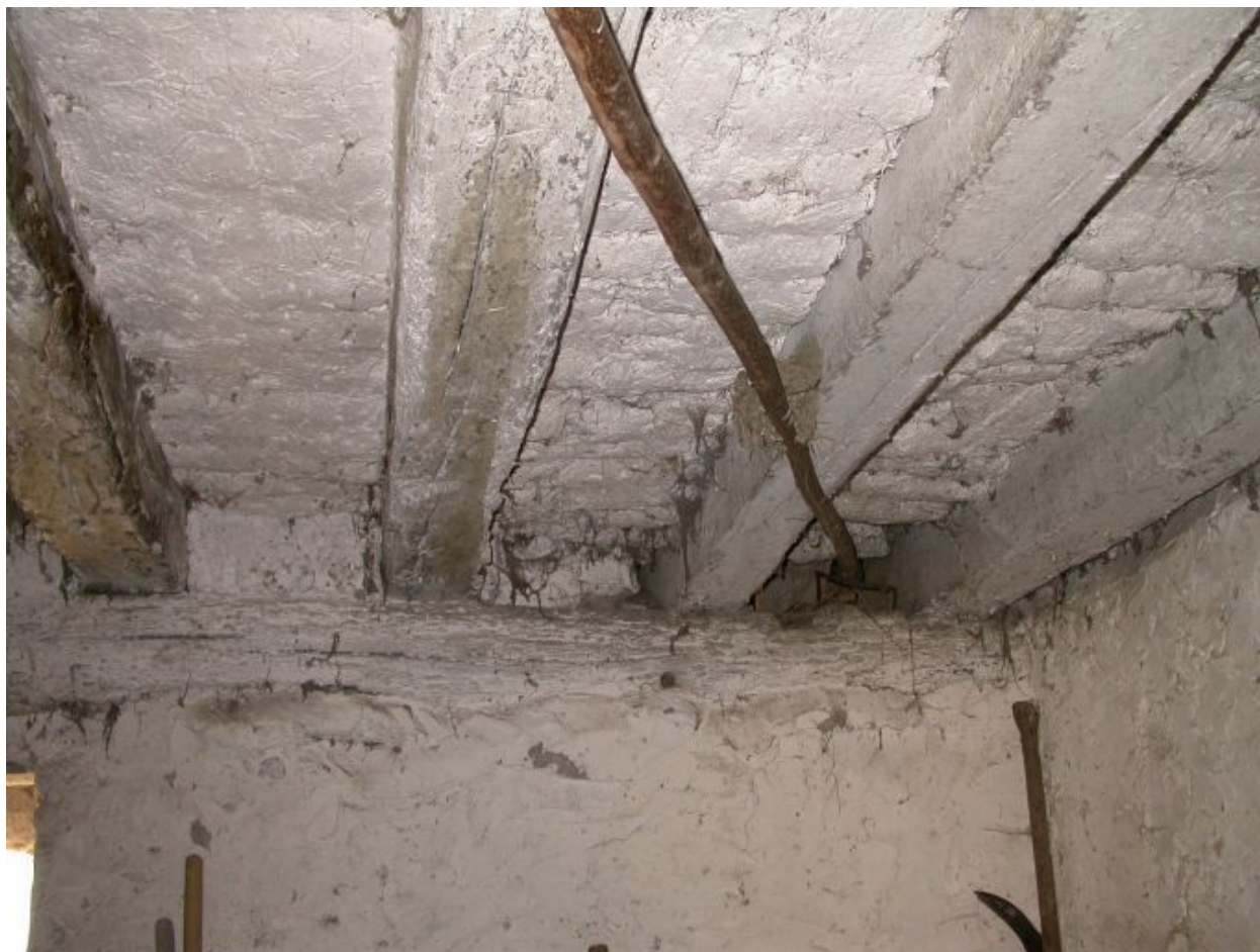
Étable, plafond : poutre de rive pour soutenir les solives (vestiges pan de bois ?)
