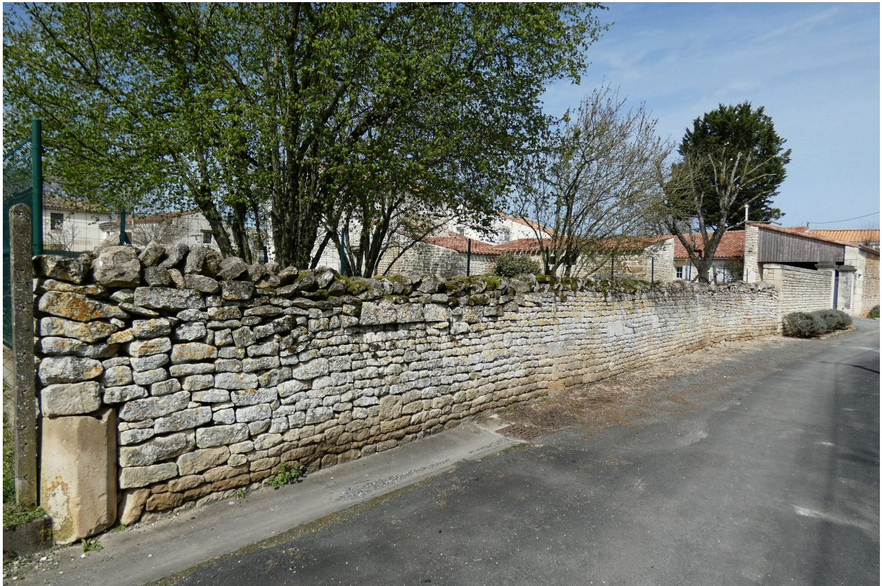
Une partie du mur de clôture.
