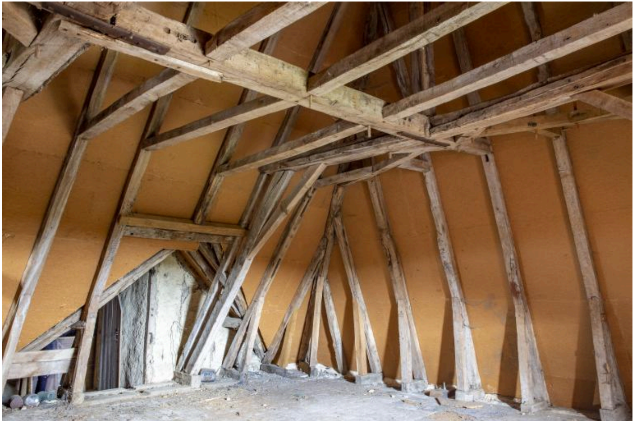
La charpente du pavillon.
