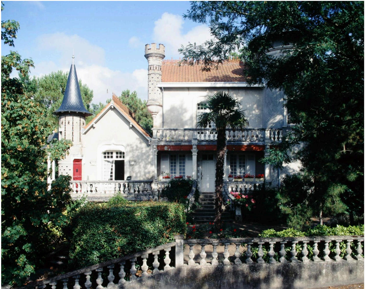
Elévation antérieure de la villa.
