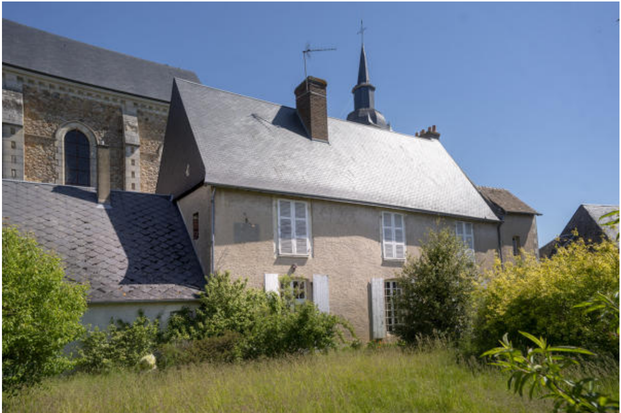
Façade principale côté jardin du presbytère.
