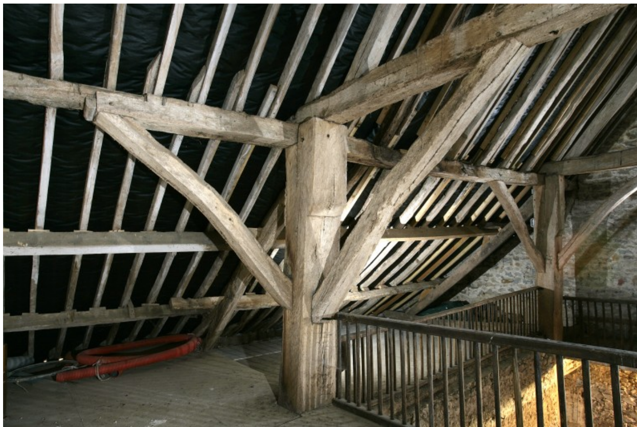
Grange-étable : la partie supérieure du poteau sud-ouest vue depuis le sud-est.
