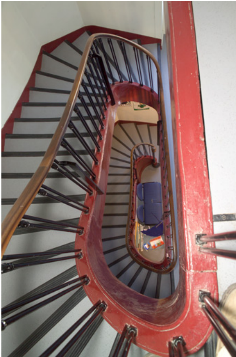
Escalier vu du comble.
