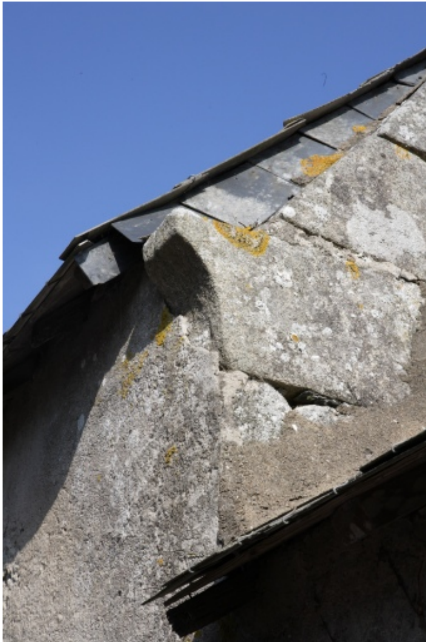
Détail du rampant se terminant par une crossette sur le pignon sud du 1er logement (1 rue des Rigadeaux).
