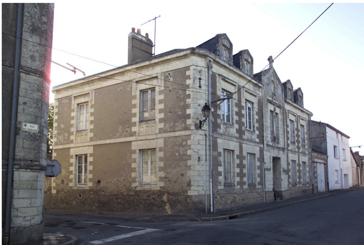
Vue de l'angle nord-ouest de l'îlot.
