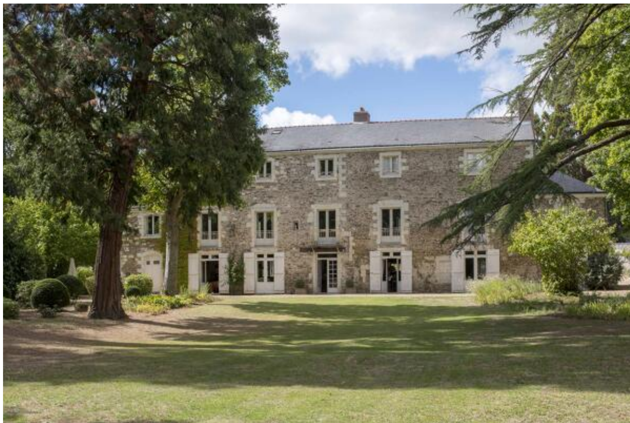
Vue de la façade est.
