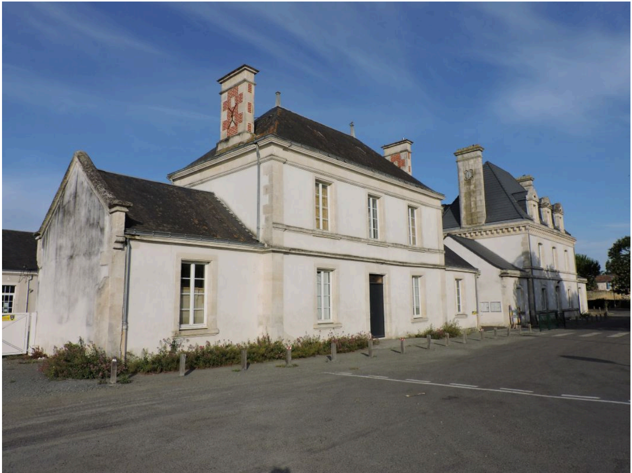
L'ancien logement d'enseignants de l'école de garçons vu depuis l'est.
