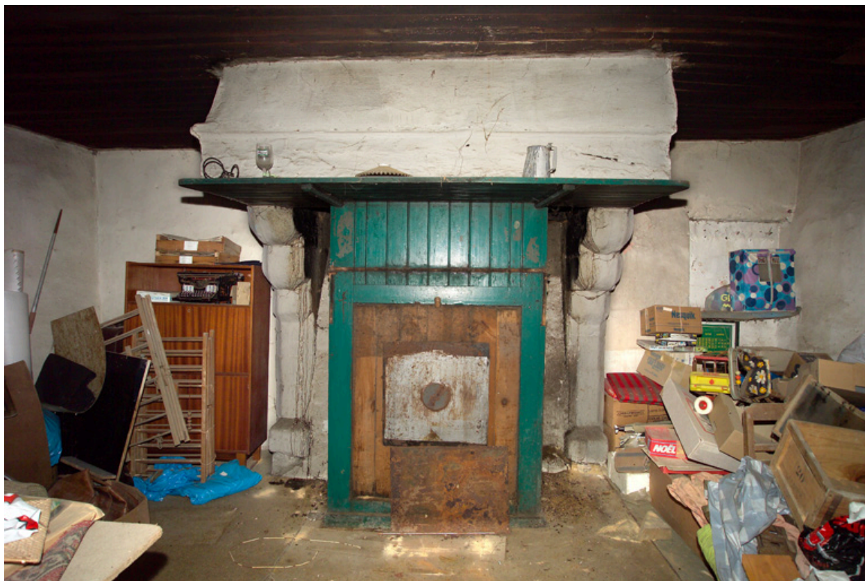
Corps principal, premier étage, pièce orientale, cheminée.
