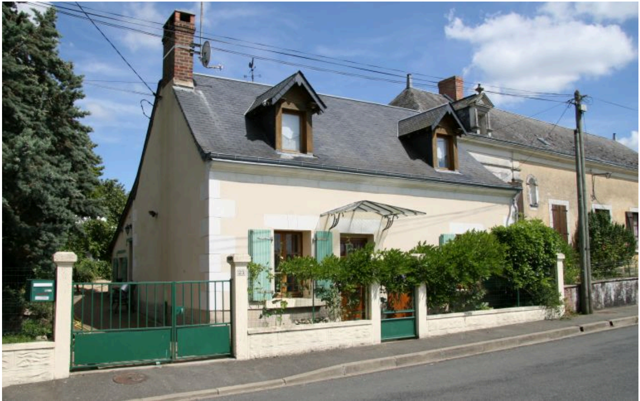
23, rue Vallon : maison remaniée.
