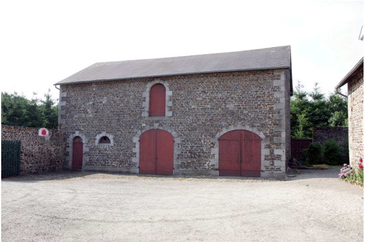
Vue depuis la cour vers le sud : l'étable-grange-remise.
