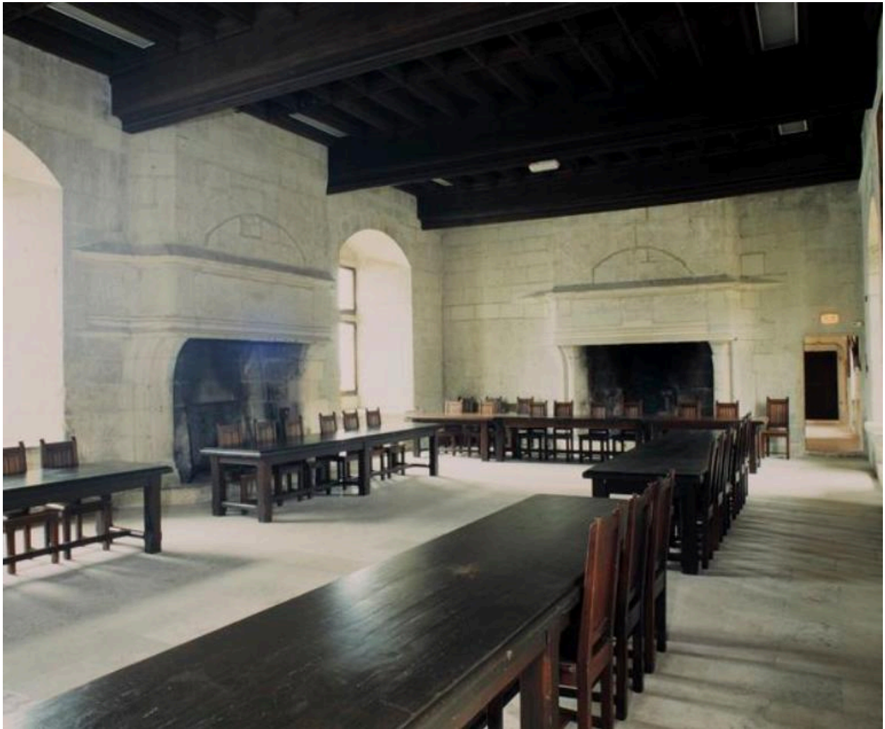
Rez-de-chaussée, grande salle, angle nord-est.
