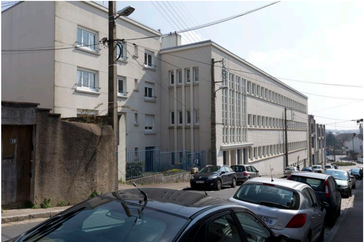
Bâtiment des années 1950.
