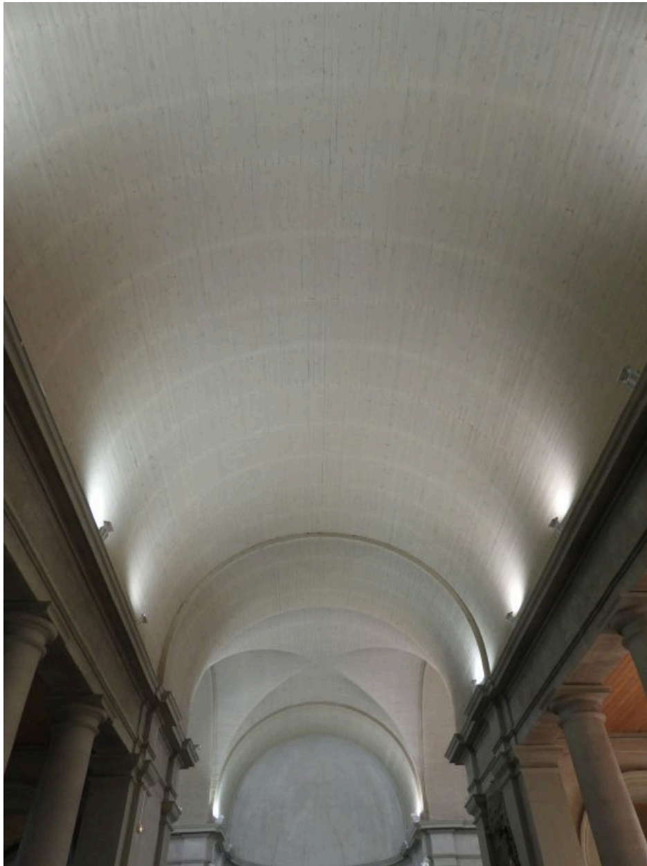
La voûte de la nef.
