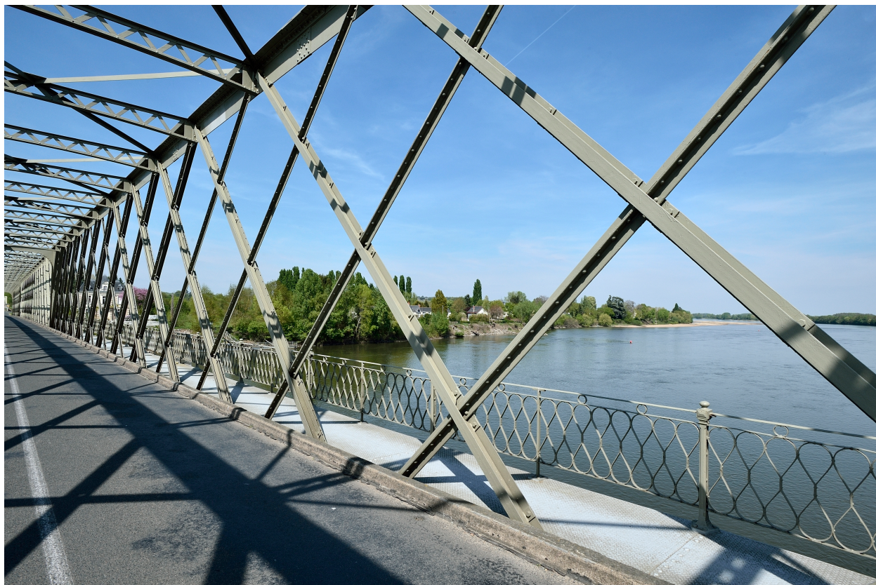
Vue des barres métalliques du pont.
