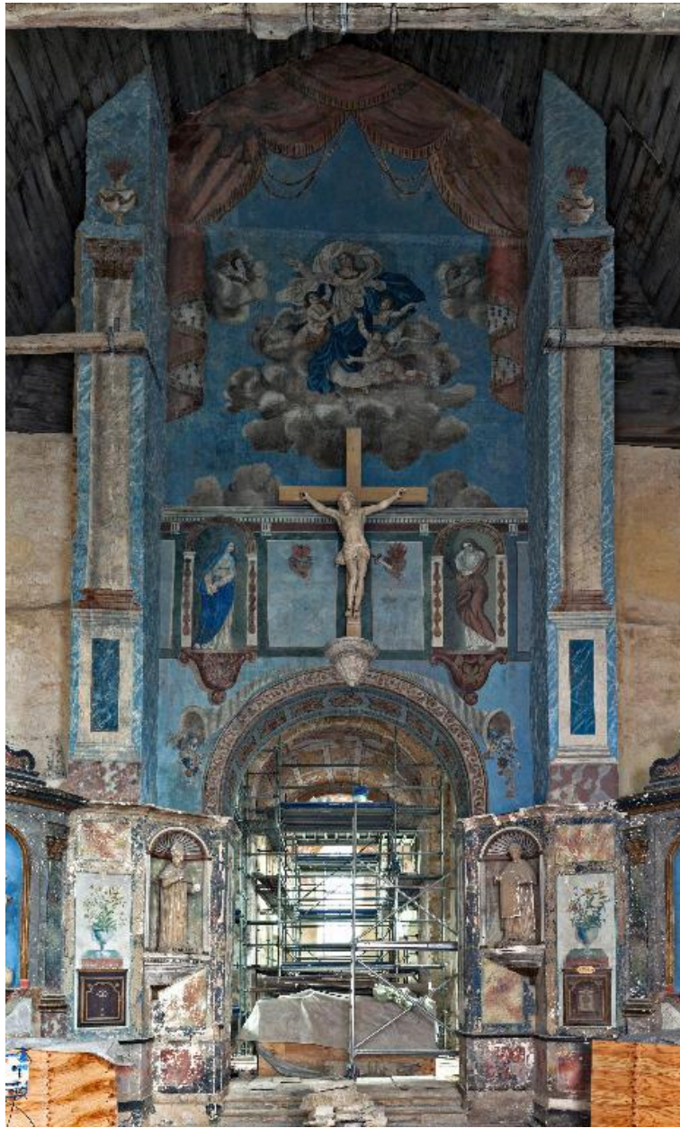
Vue d'ensemble. Après restauration.
