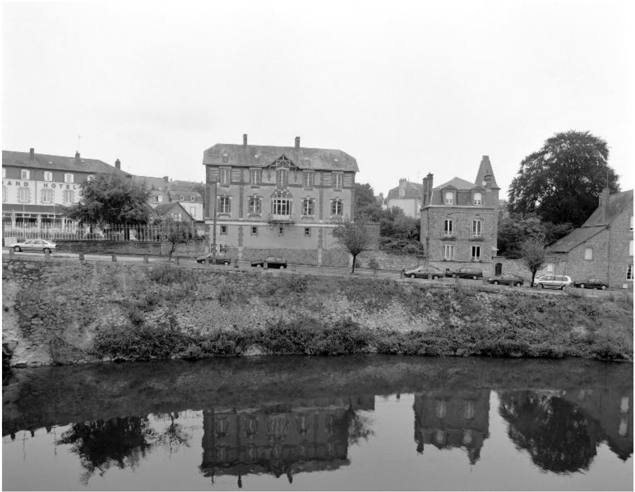
Le quai situé rive droite en amont du pont Mac Racken. Partie centrale.
