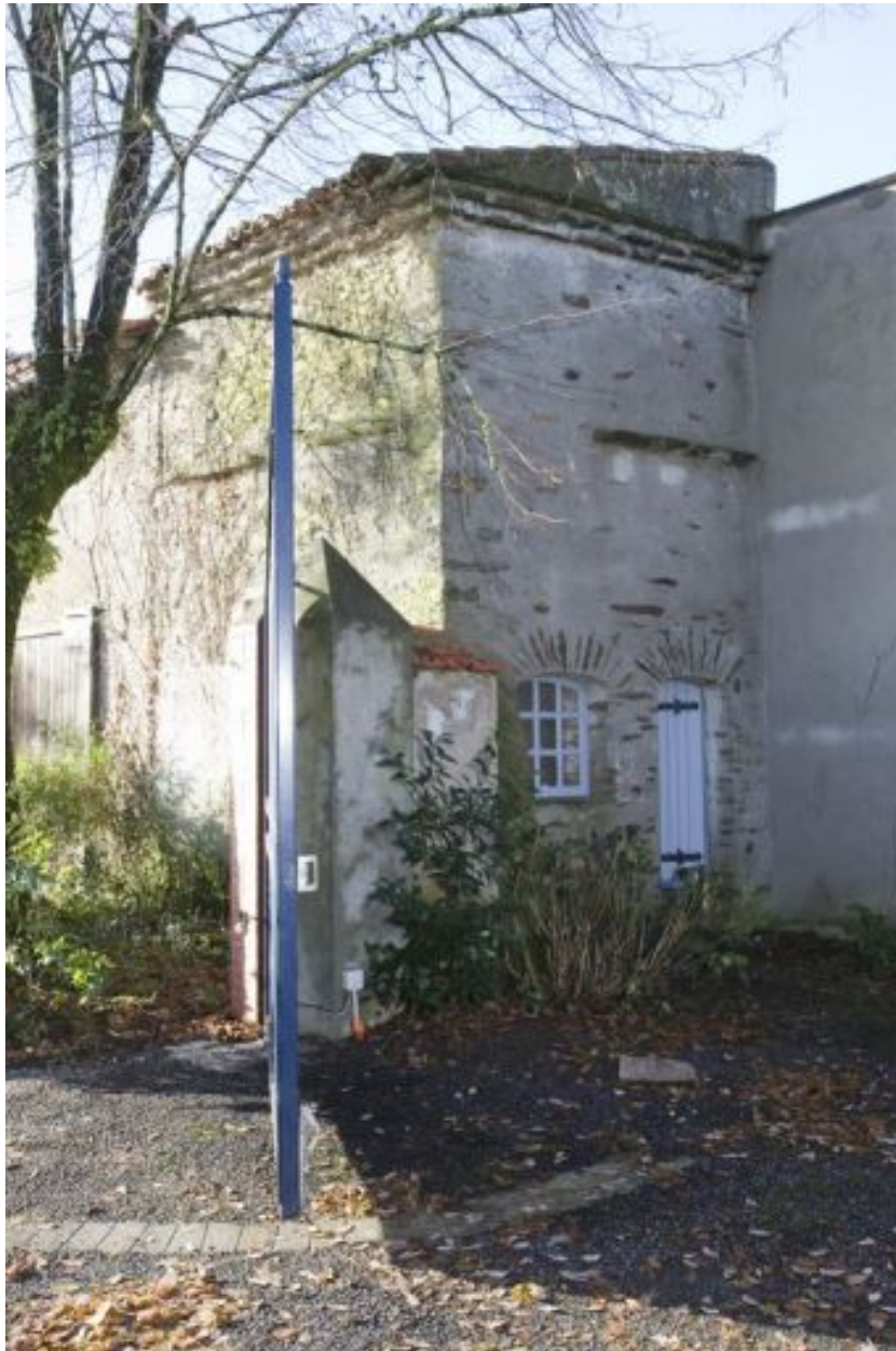
Le pigeonnier, façade nord.
