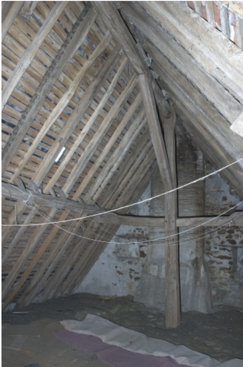
La charpente vue depuis le sud.
