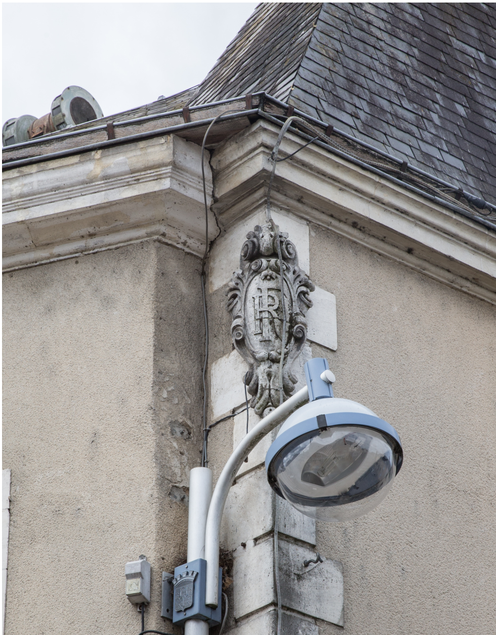
Un détail de la façade principale, le raccord des corniches.
