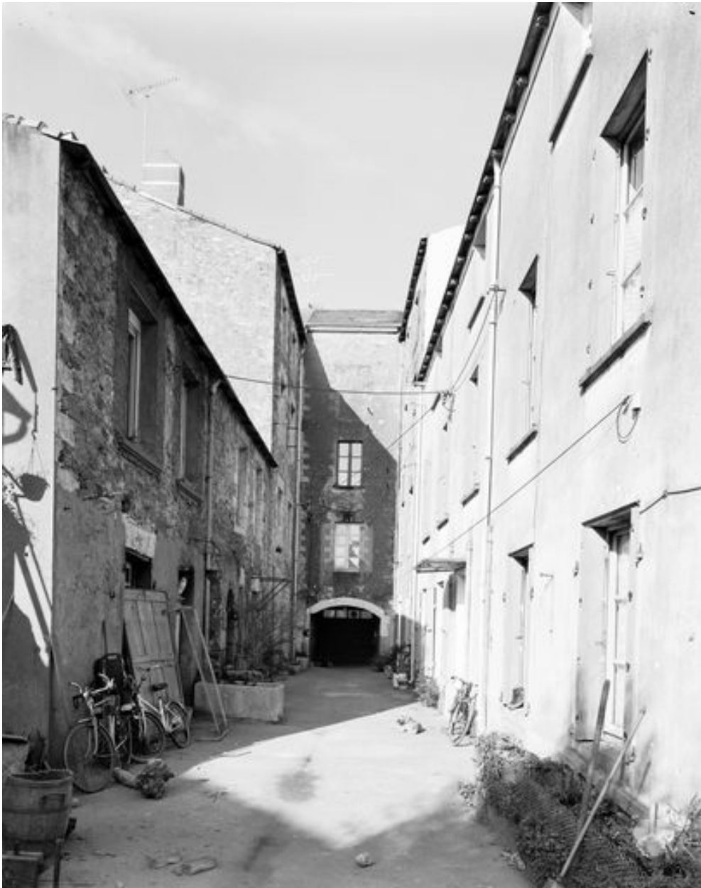
La maison n° 27, vue prise depuis la cour.
