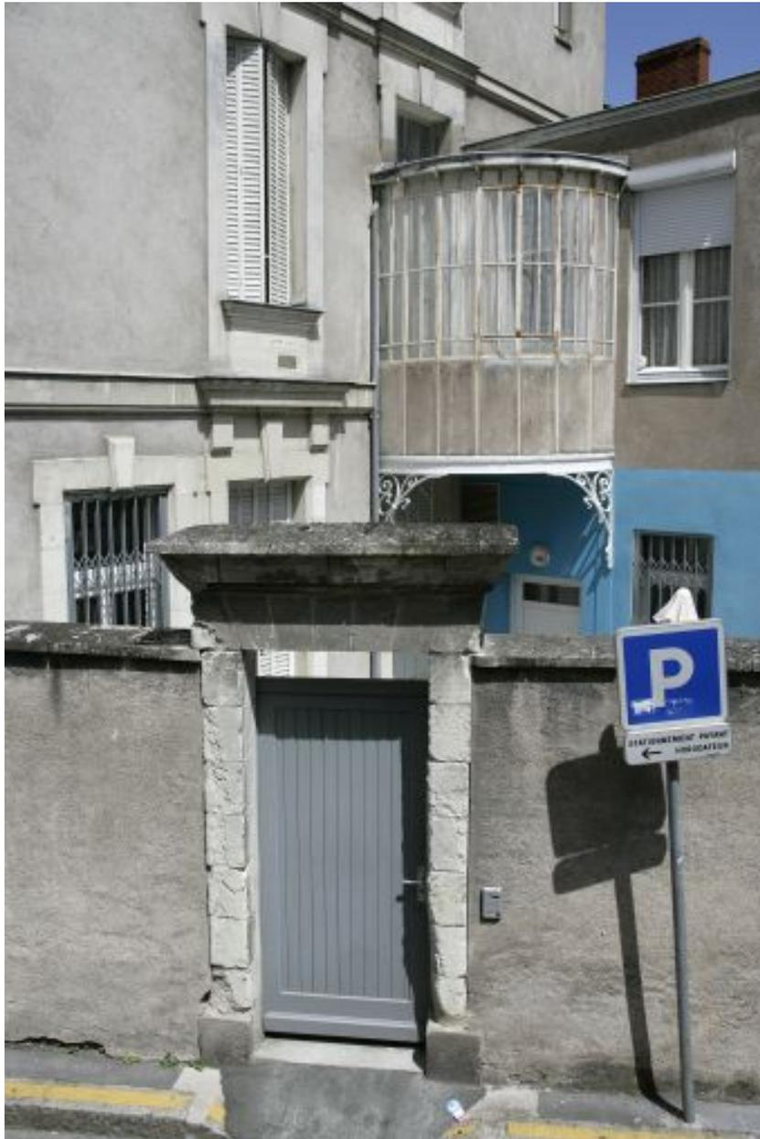
Elévation postérieure sur la rue des Cloîtres Saint-Martin : détail sur un passage vitré en encorbellement.
