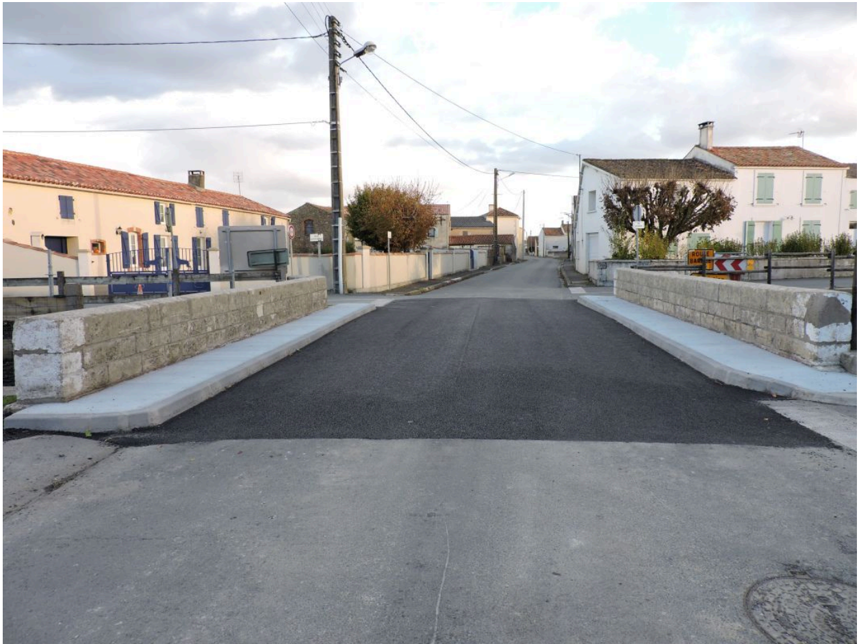
Le pont, franchi par la route départementale, vu depuis le nord-ouest avant la surélévation de ses parapets en 2018.
