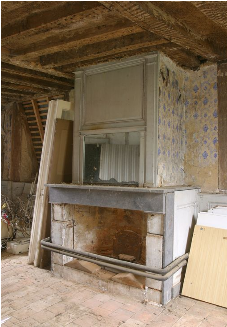
Etage de comble, pièce nord : la cheminée.
