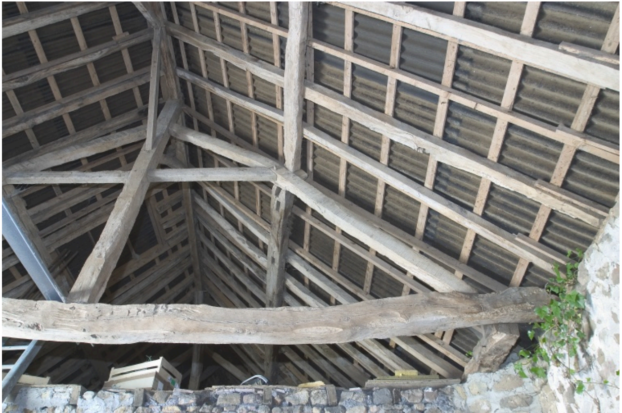
L'ancien logis-étable, charpente : la ferme V vue depuis le nord.
