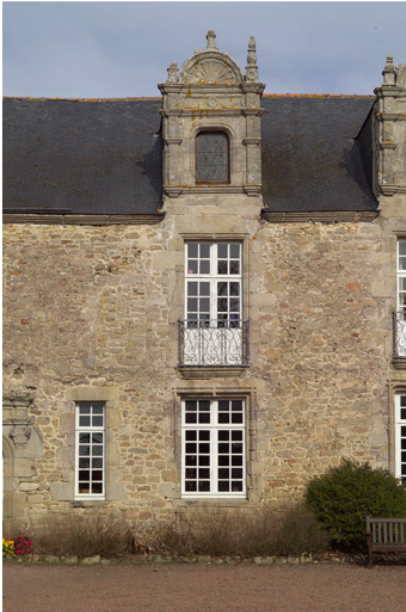
Première travée à gauche sur l'élévation antérieure du logis.
