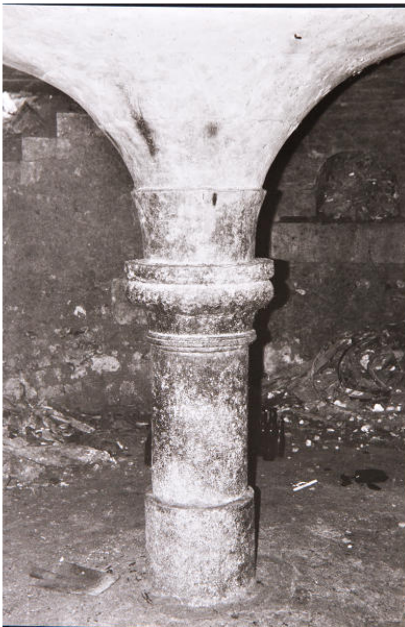
Fuie, cellier semi-enterré : colonne centrale sur laquelle retombe la voûte annulaire en arc surbaissé (cf. Cordonnier). Photo ancienne.
