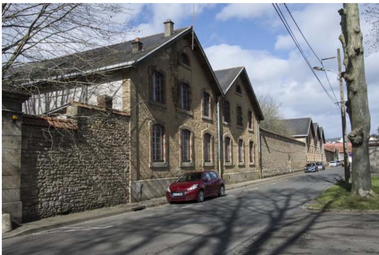
Vue des baraquements de la caserne rue des résistants internés.
